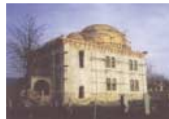
Una moschea in costruzione
