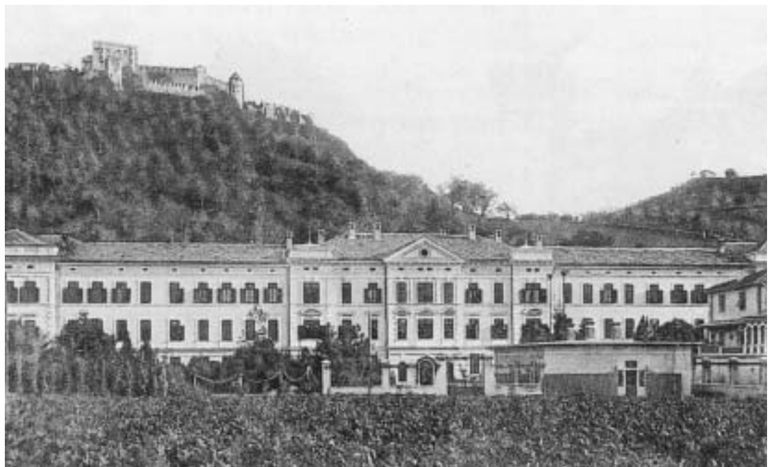
La parte centrale dell'edificio manicomiale di Pergine in una foto anteriore al 1912
